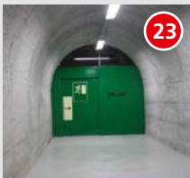
Querverbindung als Fluchtweg
