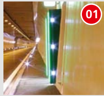
Blitzleuchten für Fluchtweg-signalisation
